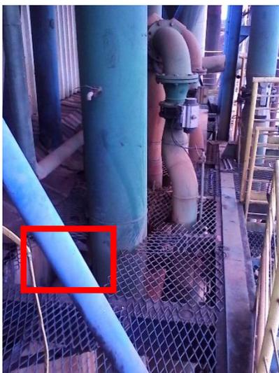
**Foto 2. A grade se rompeu na soldagem que prendia o piso na estrutura.**
