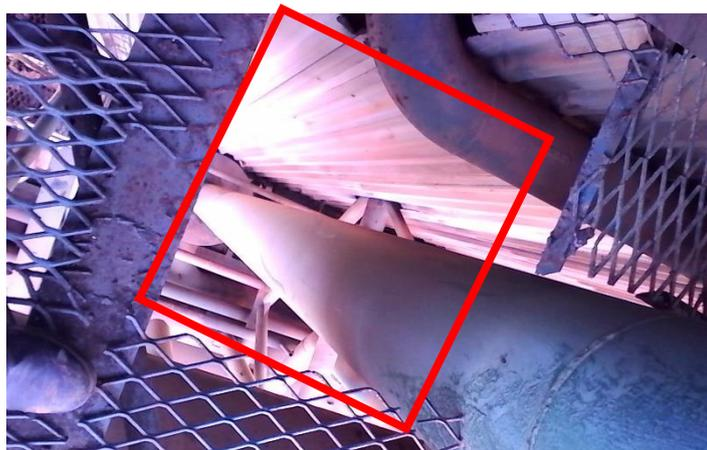
**Foto 4. A solda e presa diretamente na estrutura**
