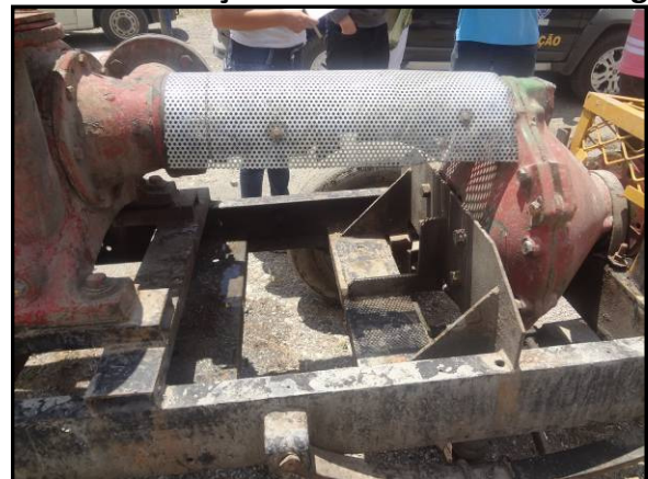
Foto 5 – Proteção fixa – eixo da bomba d'água
