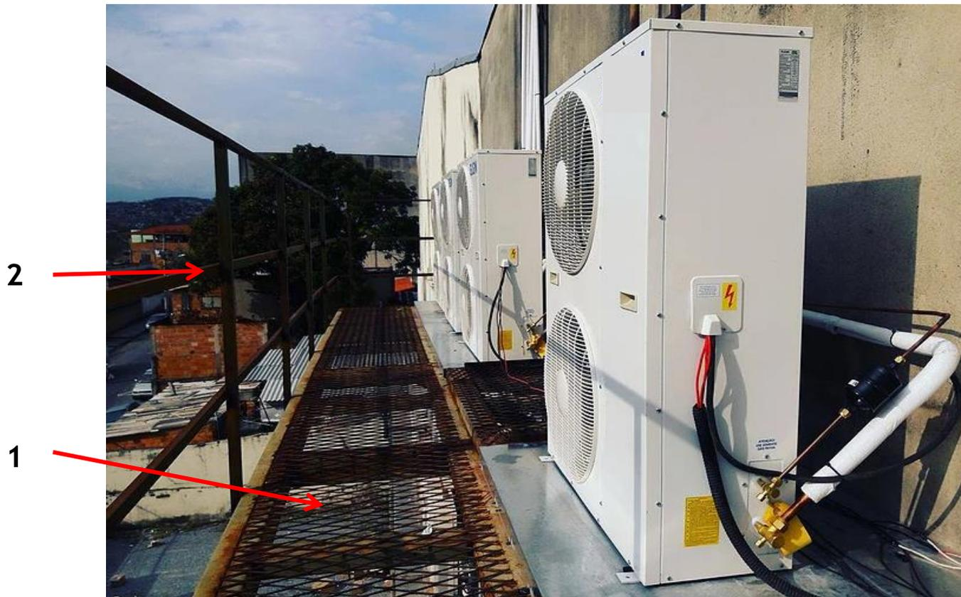
Exemplo de **Sistema de Proteção Coletiva contra Quedas (SPCQ)** para manutenção de equipamentos instalados na fachada de prédio: passarela metálica (1) com guarda-corpo rígido (2)
