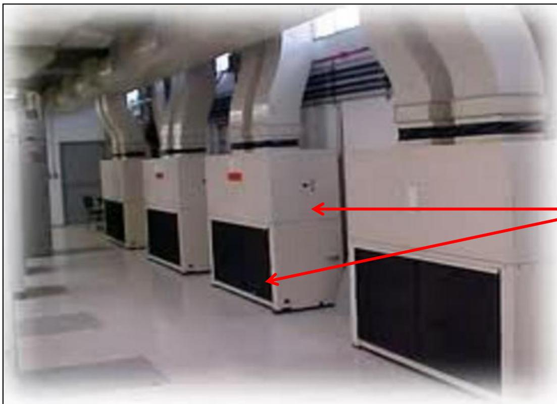
**Sistema centralizado de ar condicionado - Equipamentos com proteção física das partes móveis (ventiladores, compressores) através de grades e painéis fixos (1)**
